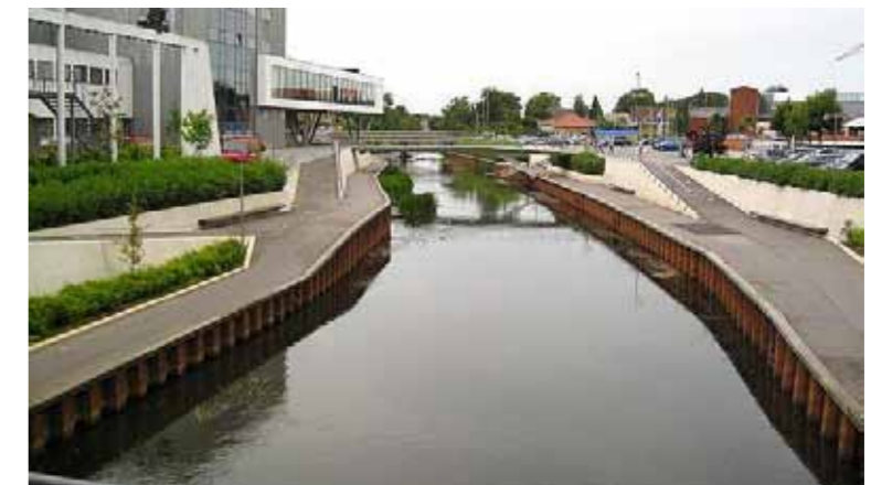
Storeåen nedstrøms mod Vest set fra Store Bro
