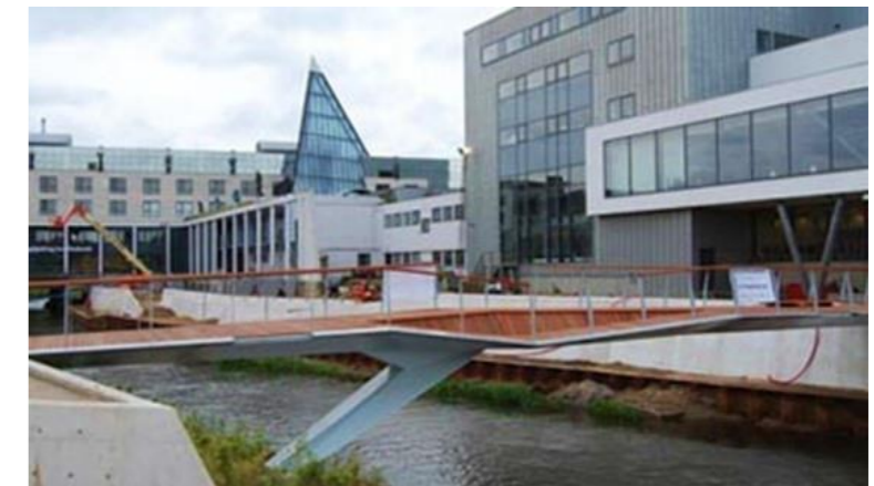
Kronen på værket blev en ny stålbro mellem nord og syd
