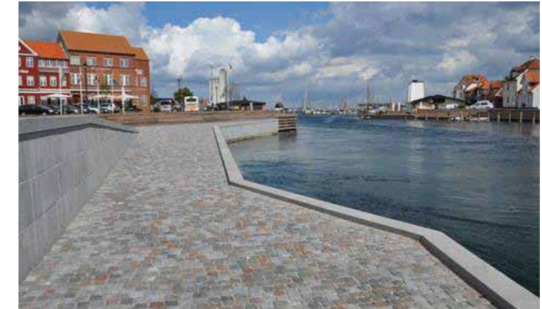
Belægningen er udført med chaussesten, der er kløvet rent
