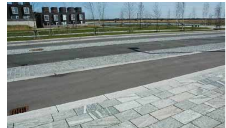
Belægninger er udført i granitfliser chaussesten og asfalt
